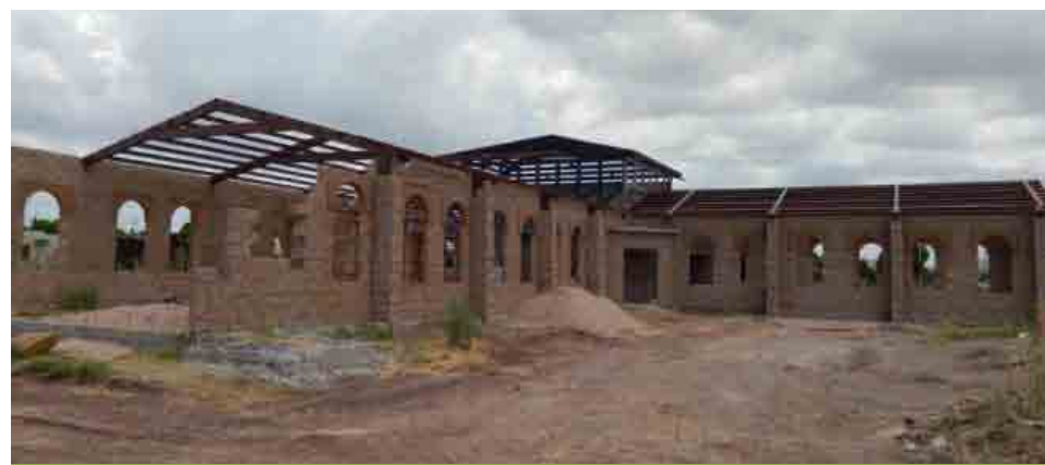
Construcción del templo de la Medalla milagrosa
